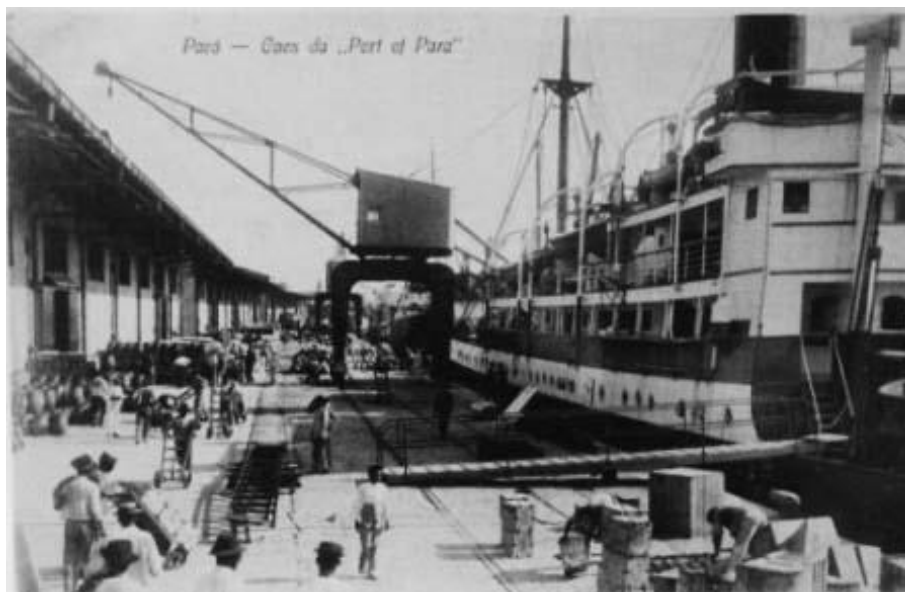
Figura 11: Cartão postal com fotografia do Port of Pará, data de 1911. Fonte: Soares, -
